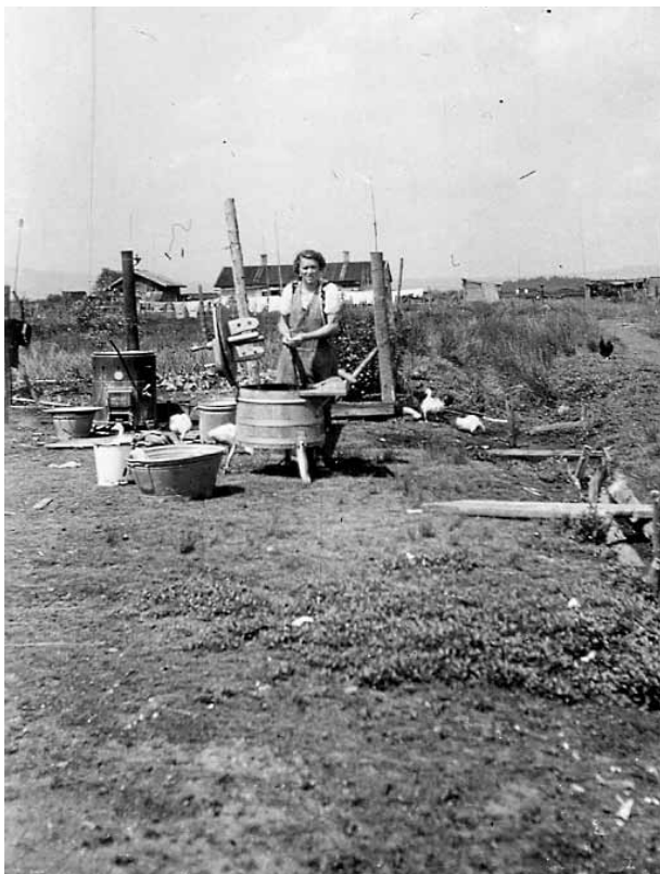
Viele Barackenbauten in der Hochrunstfilze hatten kein Waschhaus. Dann fand der Waschtage im Freien statt. Foto: Erna Schwaiger
